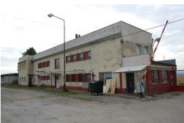
Objekt 19 – vstupný objekt s vrátnicou
