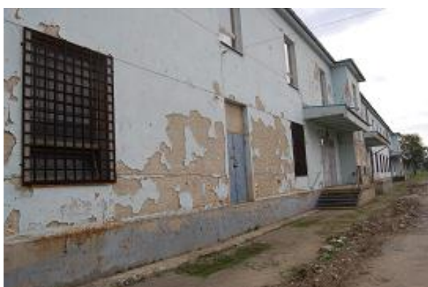
Pohľad na objekt 10 od vstupu z juhozápadu
