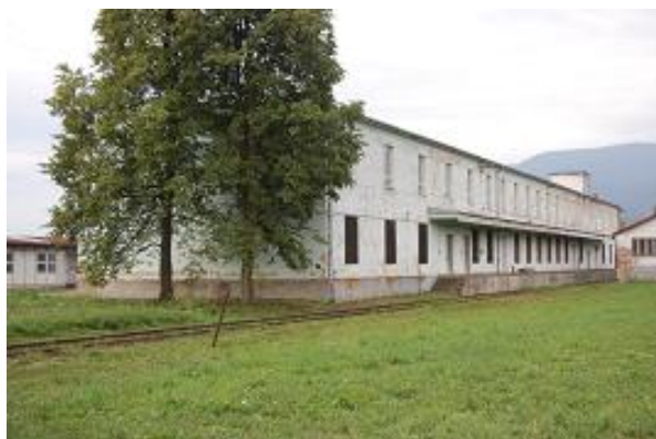
Pohľad na objekt 10 od vlečky z východu
