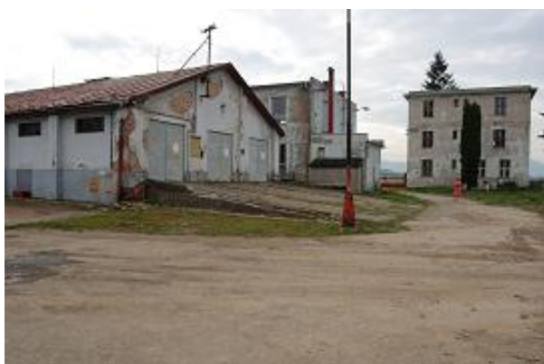
Pohľad na objekt 5 – pôvodnú administratívnu budovu
